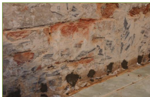
(4). Отворите се запечатват незабавно с КВ Фикс 5 КЪОСТЕР.
