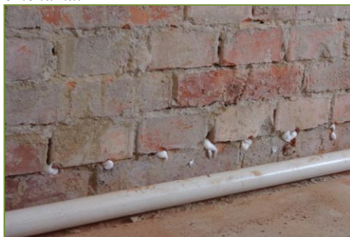
(3). Кризин Крем КЪОСТЕР се инжектира от патронника с подходящ Ръчен пистолет КЪОСТЕР.
