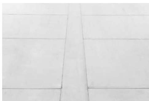
TPO лента, положена на по-голямо разстояние
