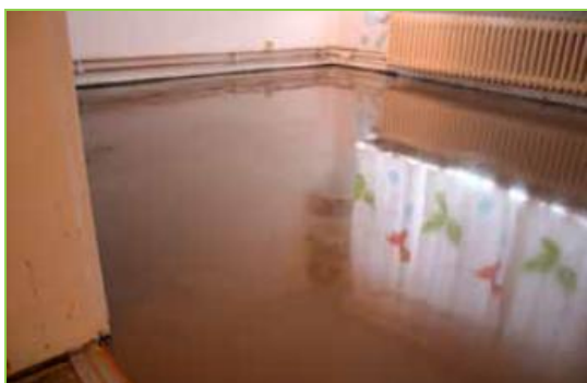
SL Премиум КЪОСТЕР и полагане на EM-VS КЪОСТЕР
