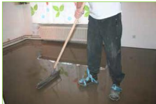
Полагане на SL Премиум КЪОСТЕР и обезвъздушаване
