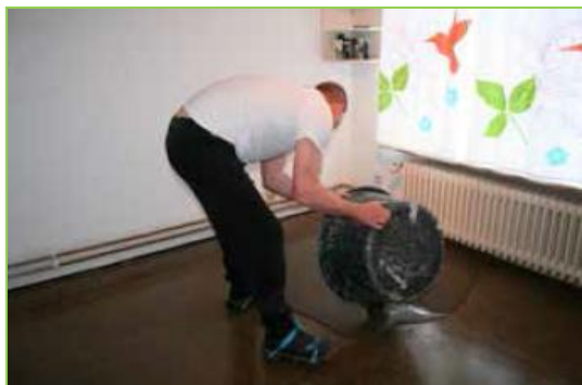
Полагане на SL Премиум КЪОСТЕР и обезвъздушаване
