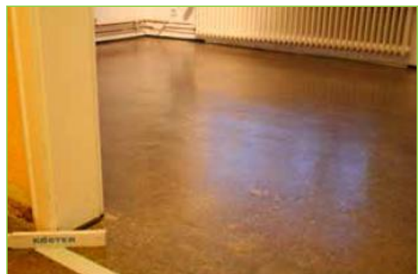
VAP I® 06 Грунд КЪОСТЕР, положен върху VAP I® 2000 КЪОСТЕР (вляво: прясно, вдясно: сухо)
