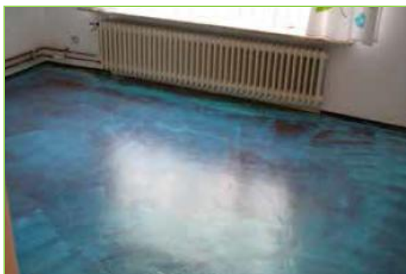
VAP I® 06 Грунд КЪОСТЕР, положен върху VAP I® 2000 КЪОСТЕР (вляво: прясно, вдясно: сухо)
