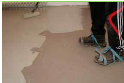
SL Премиум КЪОСТЕР и полагане на EM-VS КЪОСТЕР
