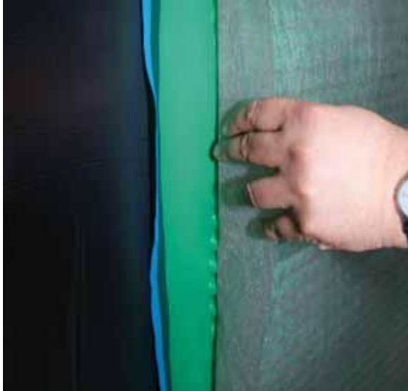
KÖSTER SD-Предпазен лист 3-400 предпазва хидроизолацията и осигурява дрениране на остатъчната вода.
