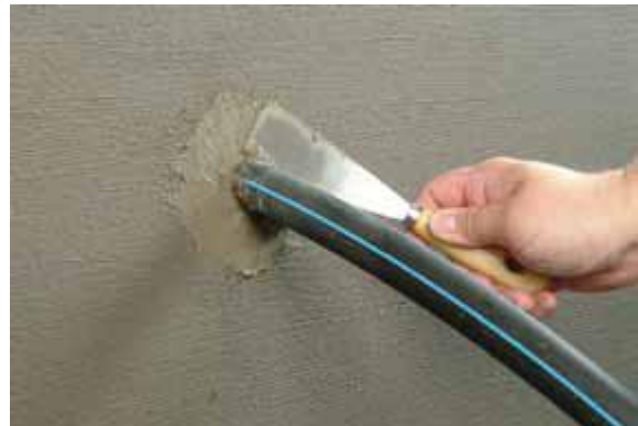
Сега тръбната разводка е вече хидроизолирана. С цел предпазването на хидроизолацията, площта около тръбата или кабела се запушва с KÖSTER KB-Фикс 5.
