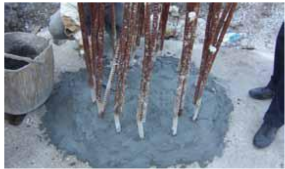
Изработване на перваз и заглаждане на повърхността с KÖSTER Разтвор за ремонти.
