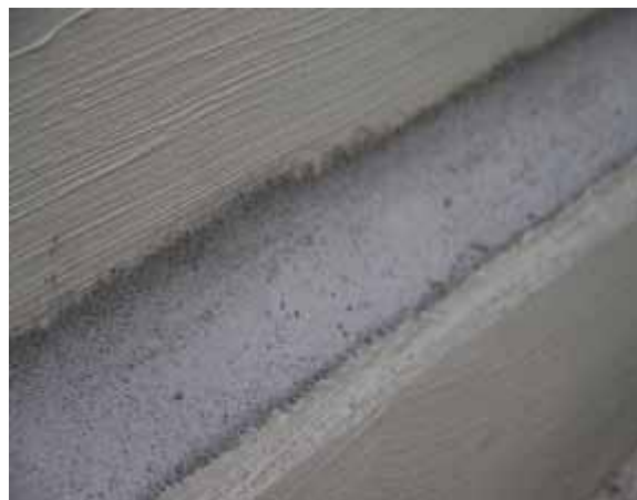
Вдлъбнати первази при връзката стена-под, направени с KÖSTER Разтвор за ремонти
