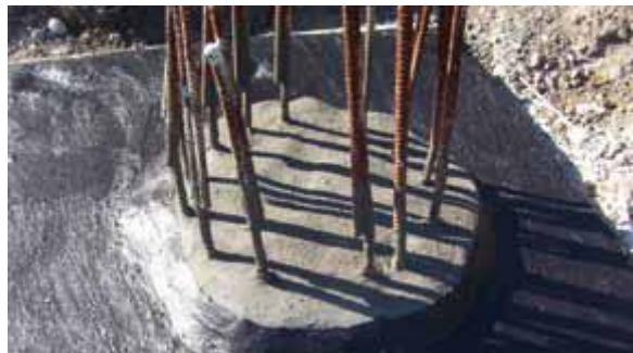
Свързване на площната хидроизолация (KÖSTER Deixan) с хидроизолацията на пилотната конструкция.
