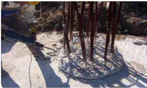
Отстраняване на изпъкналите части.
