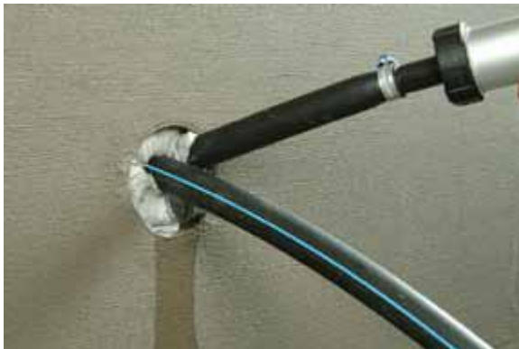
След това отворът се запълва с KÖSTER KB-Флекс 200 с помощта на специален пистолет.
