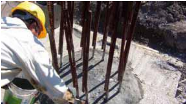
Хидроизолация на пилотната конструкция с KÖSTER NB 1 Сив.
