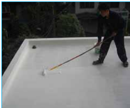
Полагане на втори слой КЪОСТЕР Еластичен покрив.
