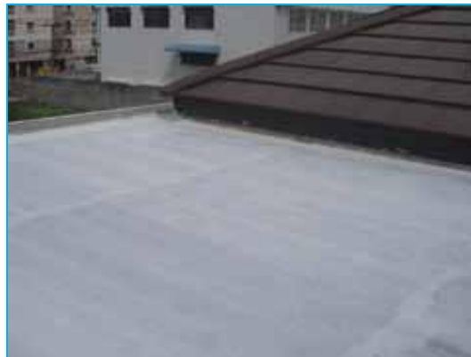
Полагане на първи слой КЪОСТЕР Еластичен покрив.
