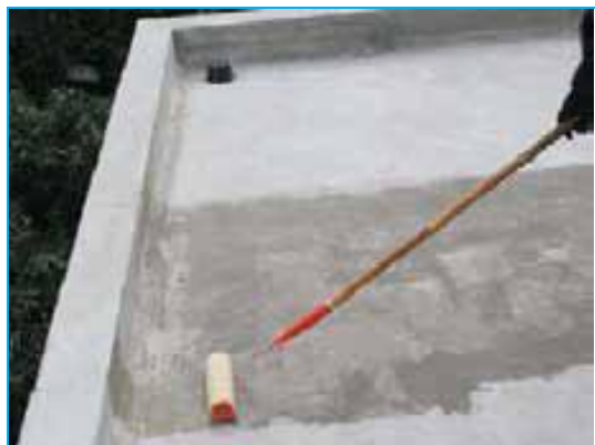
Грундиране с КЪОСТЕР POLYSIL TG 500.
