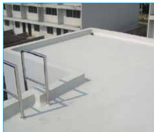
Завършена покривна изолация.
