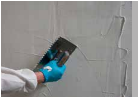
4 KÖSTER Flexgewebe wird in die erste Lage eingebettet
