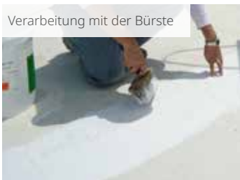
4 KÖSTER Flexgewebe wird in die erste Lage eingebettet
