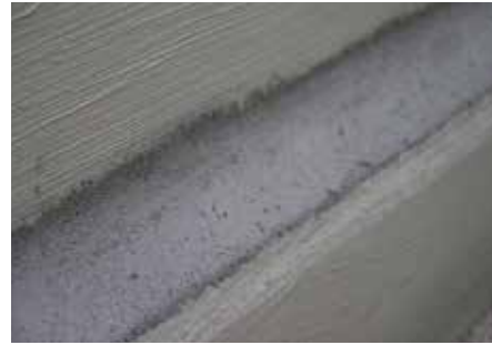
2 Hohlkehle mit KÖSTER Sperrmörtel WU
