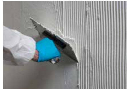
5 Auftragen der zweiten Lage KÖSTER 21
